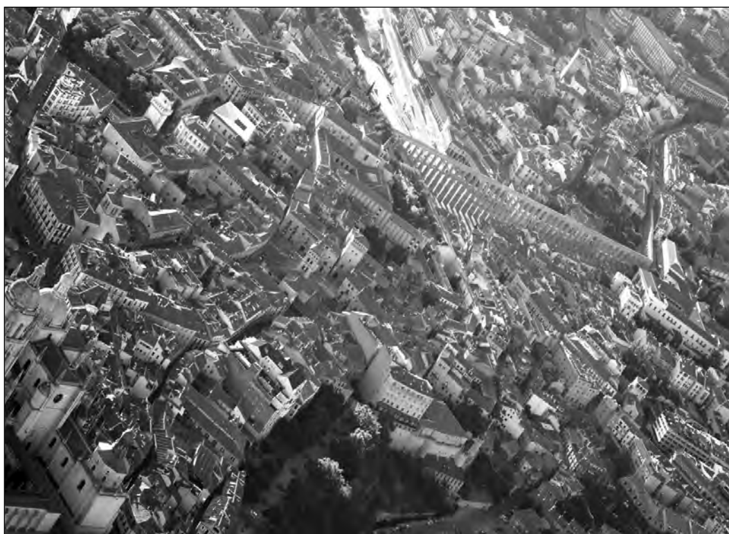
Fig. 4. Vista general del acueducto de Segovia (fotografía Miguel Zorita).
