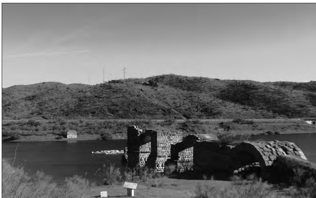
Fig. 16. Las ruinas del Puente en su actual emplazamiento (fotografía de Ana Gracia).
