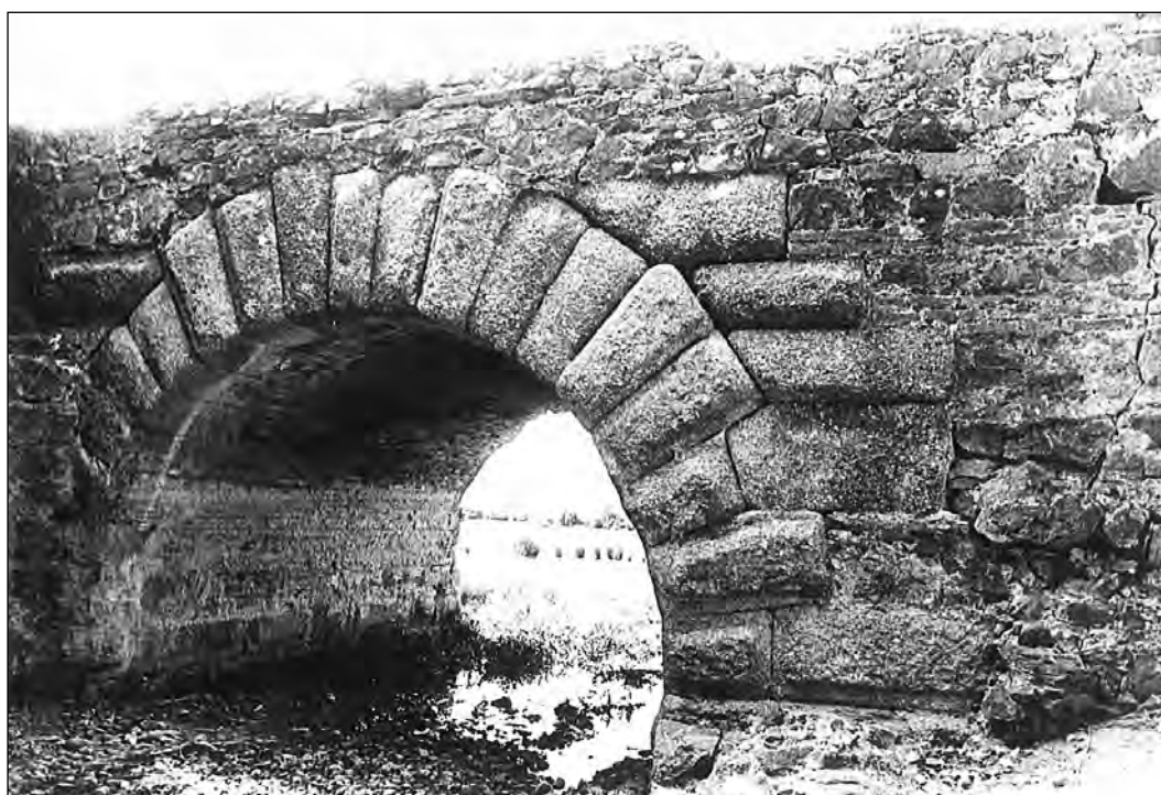
Fig. 13. Vista del puente y su arco dovelado en el tramo de aguas arriba. Archivo MNAR.
