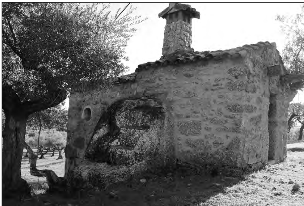
Fig. 2. Ermita del Cancho, con el altar rupestre utilizado en su muro (foto autores).
