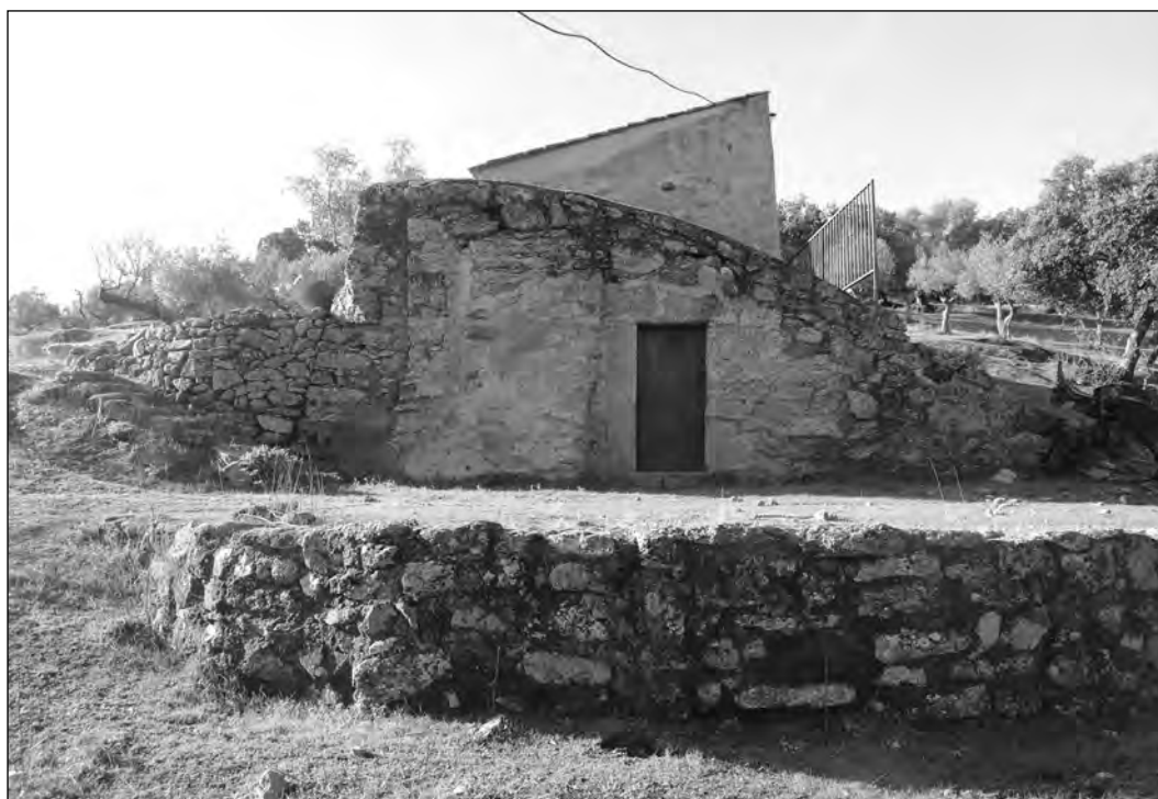
Fig. 6. Vista del exterior de la construcción semihipogea interpretada como mithraeum (foto autores).
