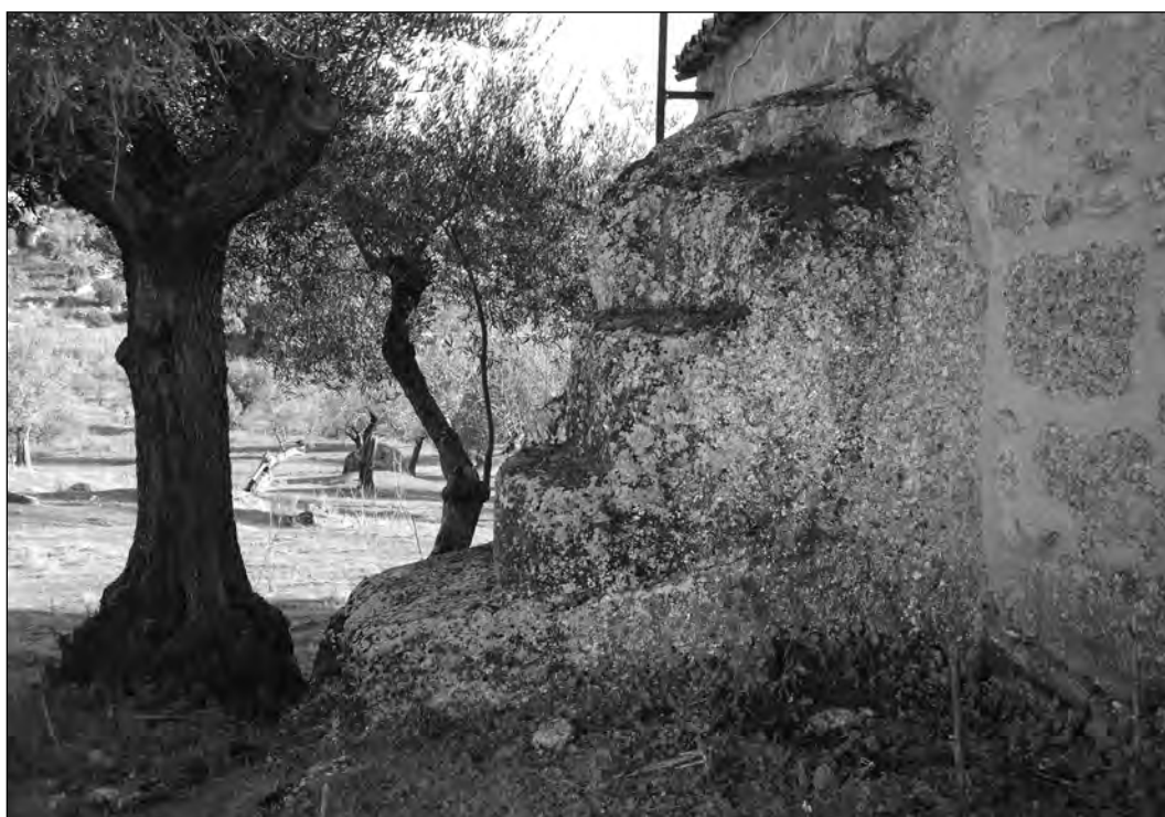
Fig. 3. Detalle del altar rupestre, cortado para alinearlo con el muro de la ermita (foto autores).
