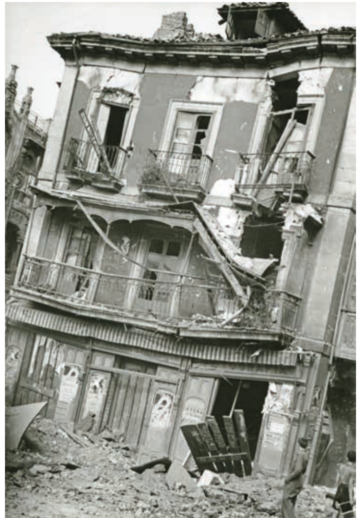
Daños producidos en un edificio de la plaza Seis de Agosto por los bombardeos de la aviación franquista. Gijón, 14 de octubre de 1937.
