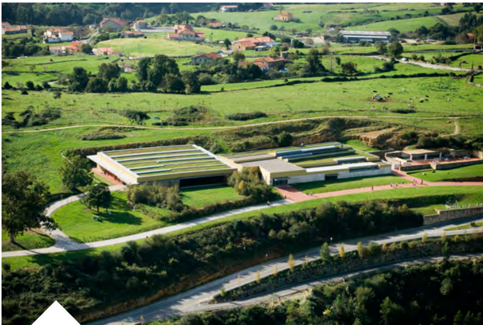
Foto 2. Vista aérea del nuevo edificio para Museo de 2001. © Banco de imágenes de Cantabria.
