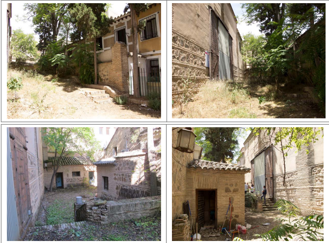
Fotografías del estado del patio antes de la intervención.
