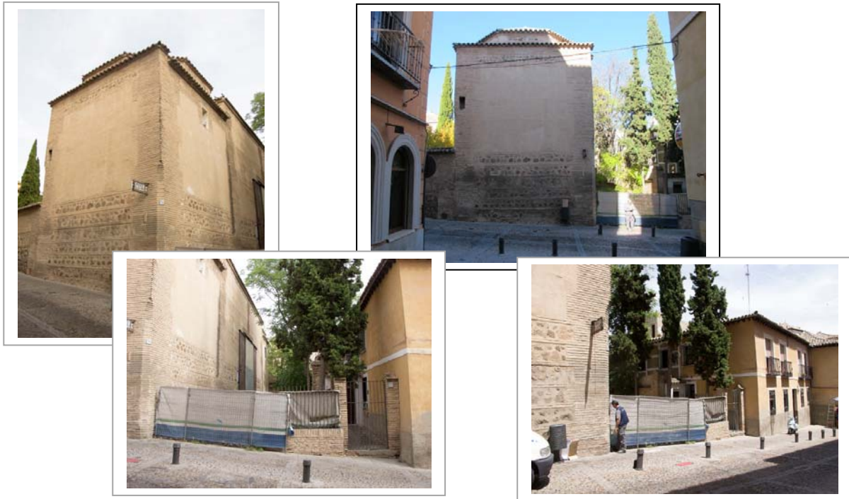
Fotografías del estado previo a la intervención del cerramiento de la parcela.
