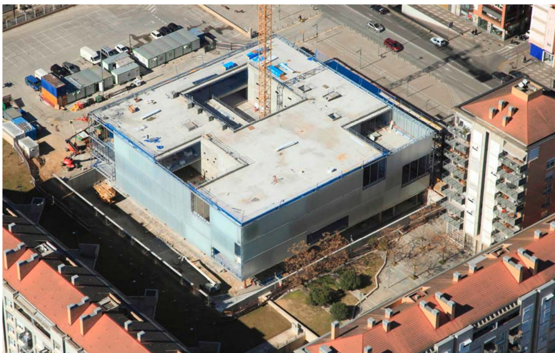
Fotografía aérea de la obra (Febrero 2012).
