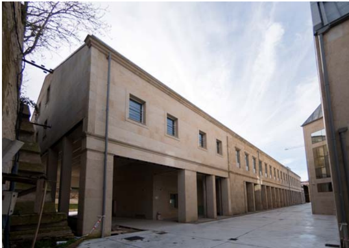
Edificio de depósitos del Archivo.
