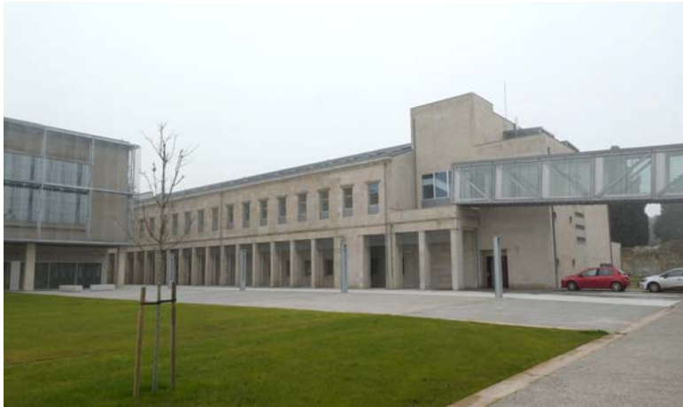
Depósitos del Archivo con pasarela de conexión al edificio principal.
