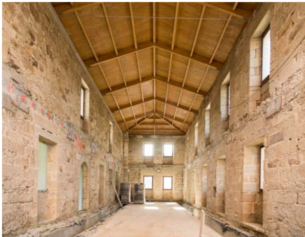
Fotografía del interior del edificio del Archivo durante las obras.
