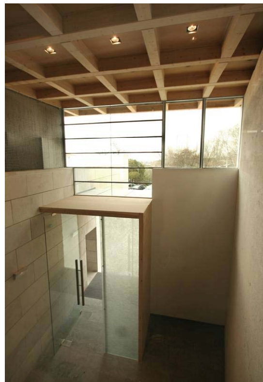
Vista del acceso desde el interior
