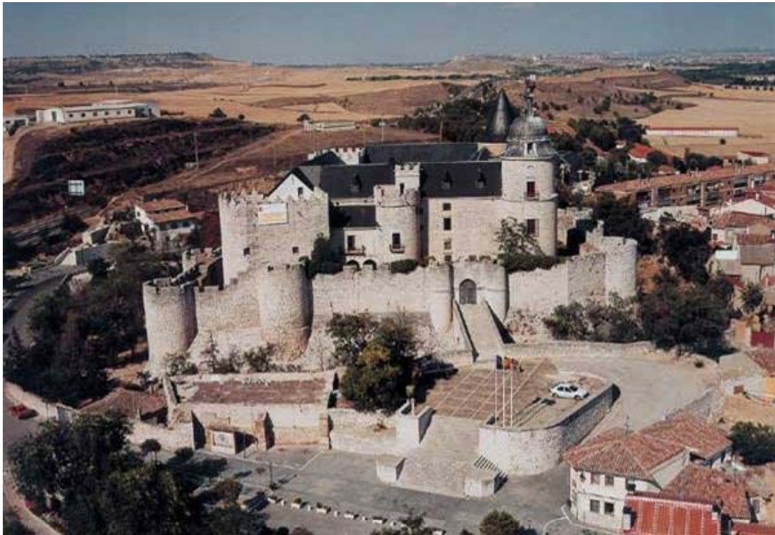
Estado previo a la intervención
