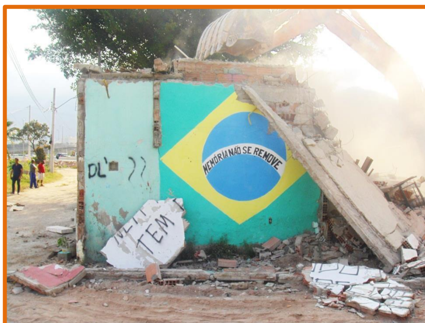
Demolición de la casa original de Sandra Regina Damião, vecina de Vila Autódromo que consiguió permanecer en la comunidad. Fotografía: Luiz Claudio Silva, 2016.
